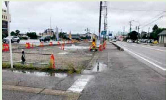
国道8号現道拡幅工事（入善町役場前）
