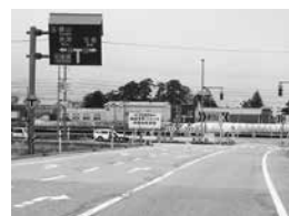
国道8号バイパス (古御堂～江口間)
