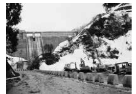
舟川ダム工事
